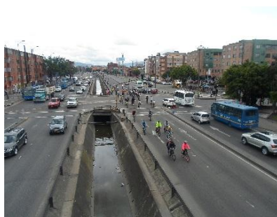
Ilustración 54. Caño contaminado de la av. Boyacá con 53. Tomada por Abello (2016).
