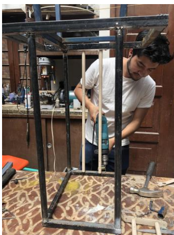
Figura 102. Estructura completa soldada.
