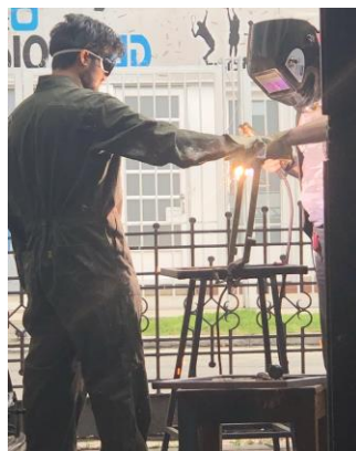
Nota: Soldadura del seguro con arco eléctrico. Fuente: Autores.
